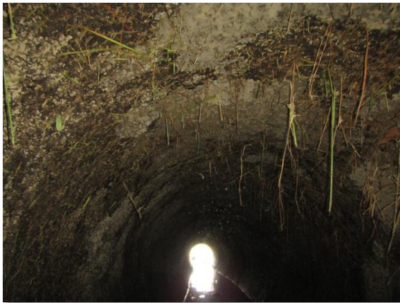
IMG_4018. Pipe Crown
