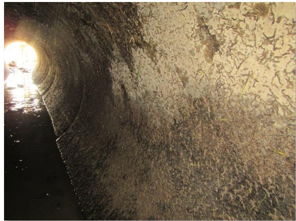
IMG_4059. 48-inch North Pipe Wall (D)
